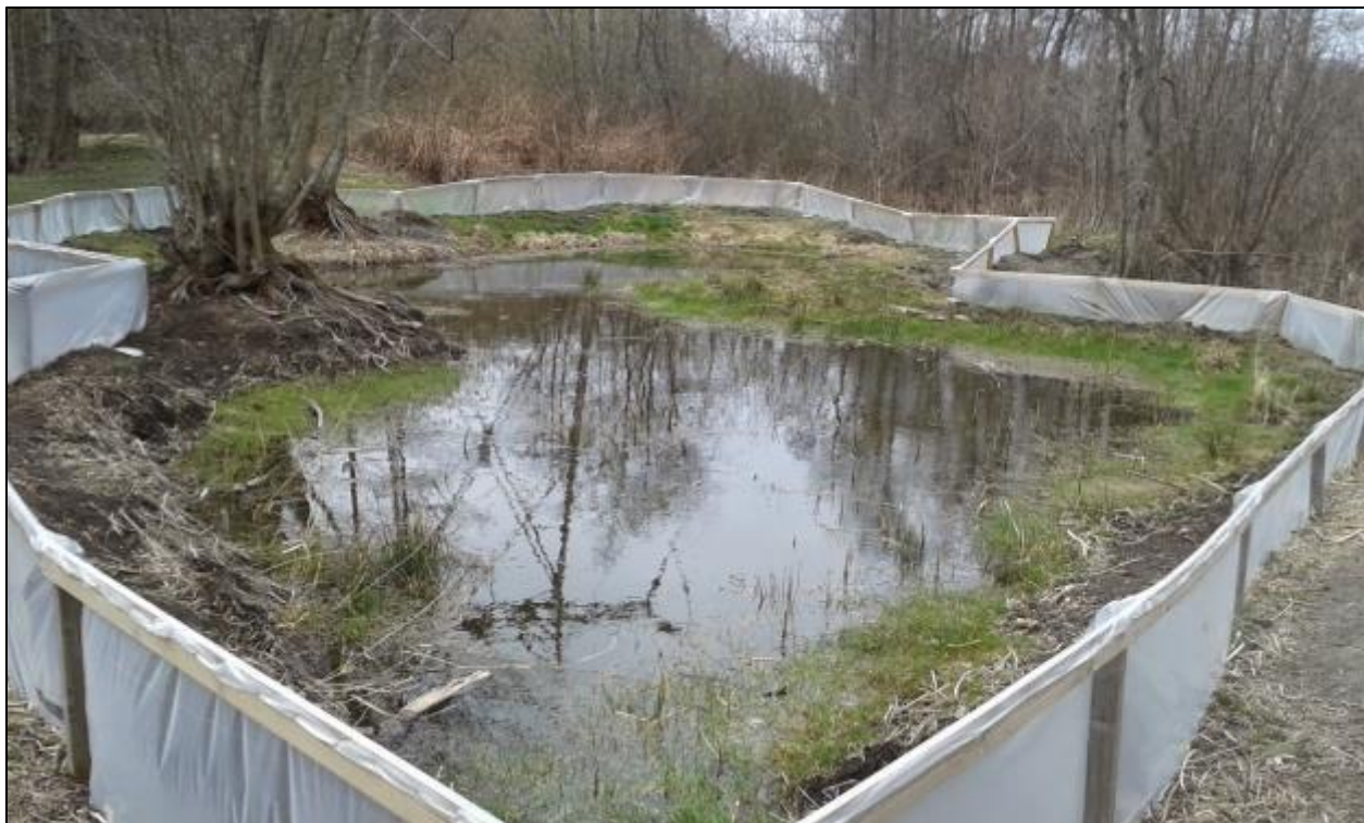
Figur 6. Runt Kyrksjödammen sattes det upp ett cirka 50 cm högt driftstaket av UV-beständig byggplast. Foto: Martina Kiibus.
